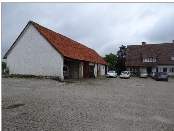
Abb. 5-3: nördliches Fachwerkgebäude mit anteiliger Garagennutzung
