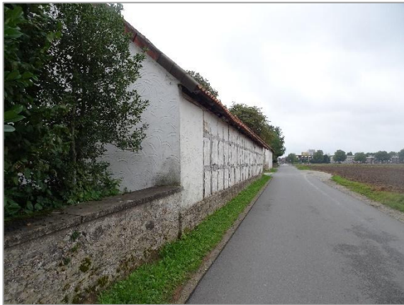
Abb. 5-5: Blick auf die beiden Fachwerkgebäude von der Ulmenallee aus mit Teilabschnitt Mauer
