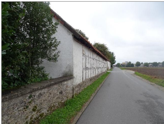
Abb. 2-6: Blick auf die beiden Fachwerkgebäude von der Ulmenallee aus mit Teilabschnitt Mauer
