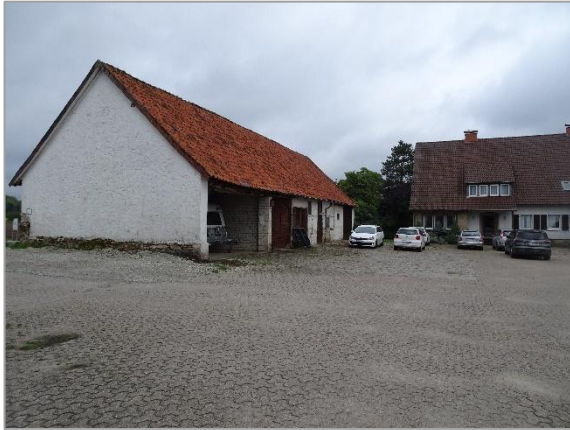
Abb. 2-4: Nördliches Fachwerkgebäude mit anteiliger Garagennutzung
